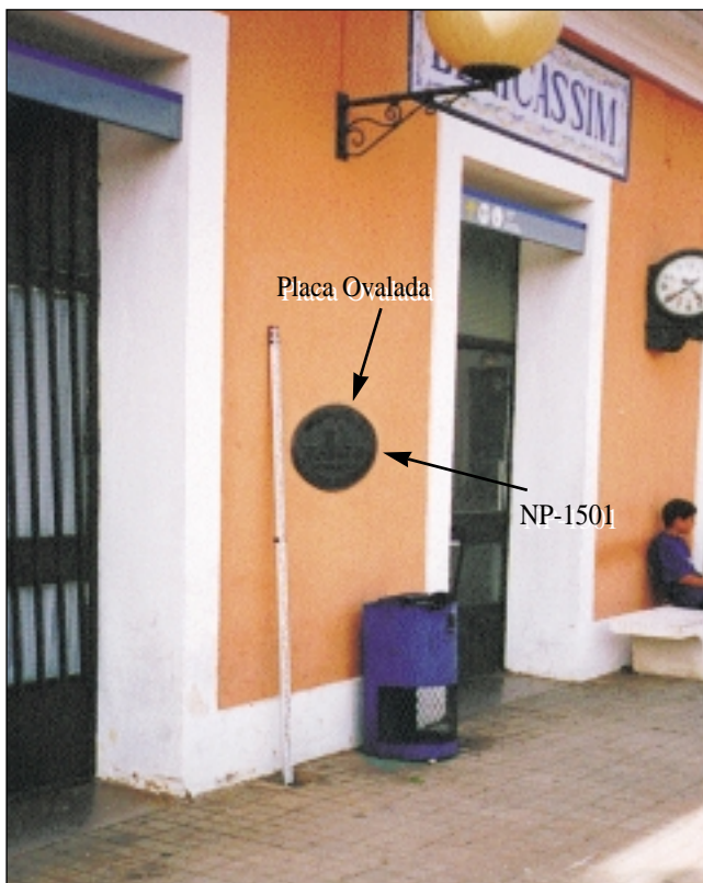
Figura 2. Punto de nivelación NP-1501 en la estación de Benicassim y placa ovalada de nivelación correspondiente.
