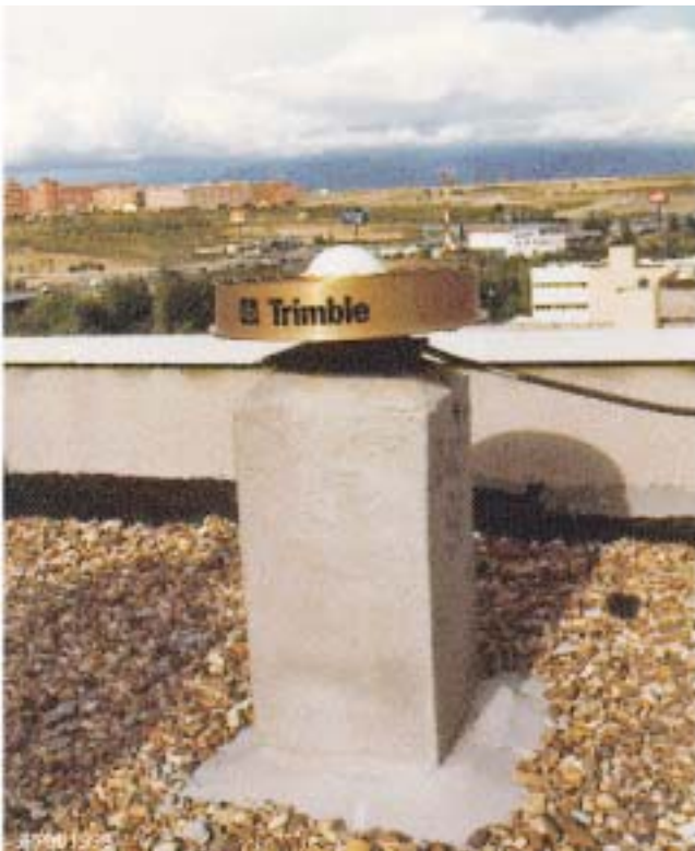
Estación permanente GPS en la E.U. de I.T. Topográfica. UPM
