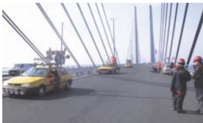
Figura 6. Los equipos sueco y danés de nivelación motorizada sobre el Puente Alto
