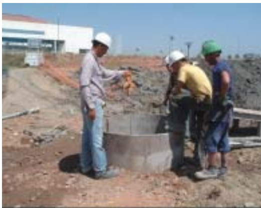
Fotografía 5. Comprobación de profundidad.
