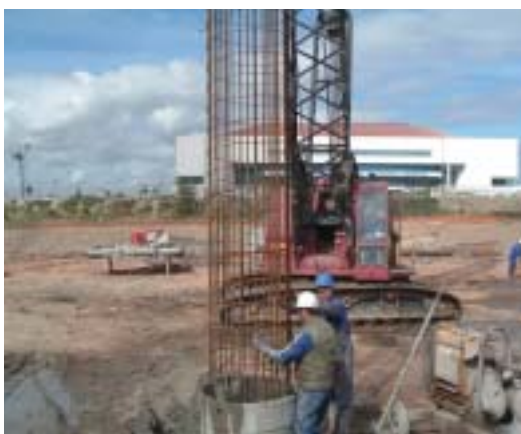
Fotografía 6. Introducción de la armadura.
