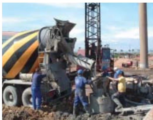
Fotografía 8. Hormigonado del pilote.
