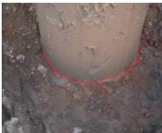
Fotografía 2. Presentación de la camisa sobre el pilote replanteado.
