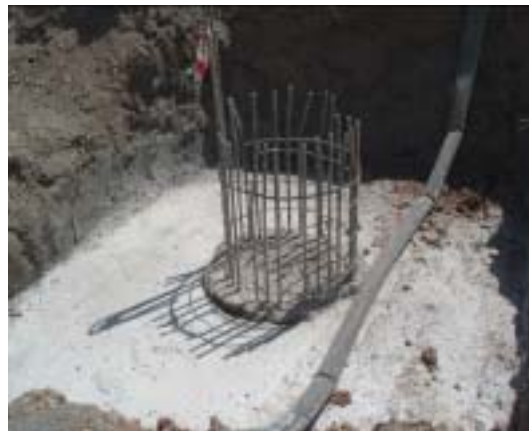
Fotografía 12. Pilote preparado para ejecutar su encepado.
