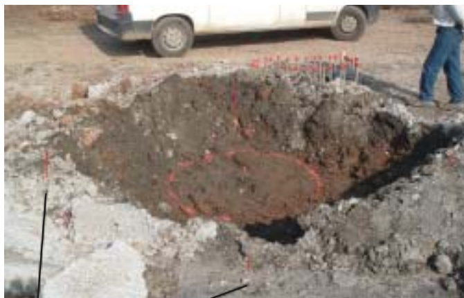
Fotografía 1. Tochos dispuestos alrededor del pilote y separados del centro una distancia de 2,25 m en los pilotes de 1.500 mm.
