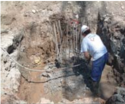
Fotografía 11. Descabezado manual del pilote con un martillo compresor.
