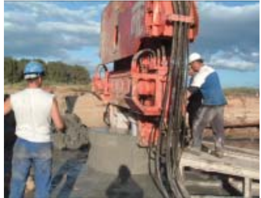
Fotografía 10. Inicio de extracción de la camisa. Se acopla el vibrador a la camisa con unas pinzas hidráulicas.
