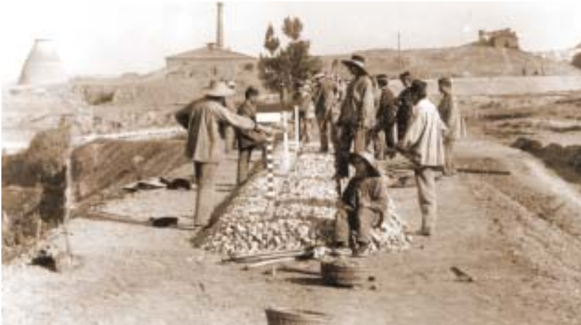
Caso real de empleo de las niveletas en la construcción del ferrocarril del siglo XIX.
