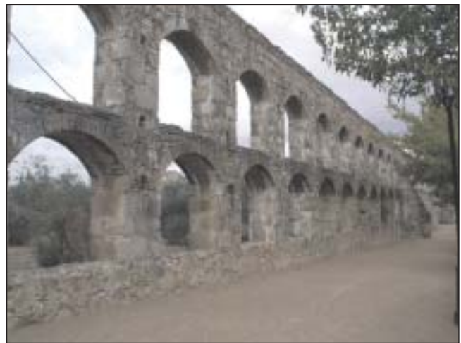
Figura 1. Vista general del acueducto.
