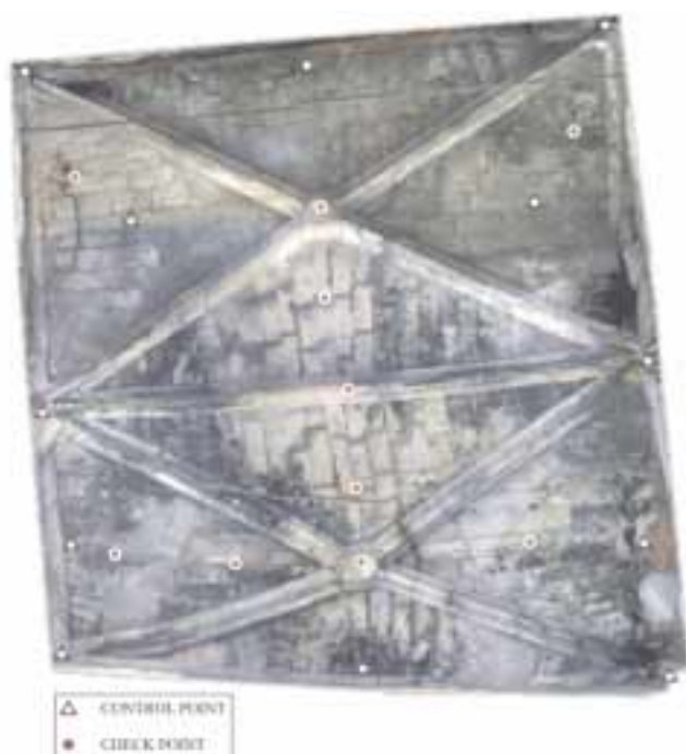
Figura 5. Ortofotografía (GSD de 3 mm) de la bóveda de la Capilla Mayor de la Iglesia de Santo Domingo de Silos. Se indica la red de puntos de control y comprobación
